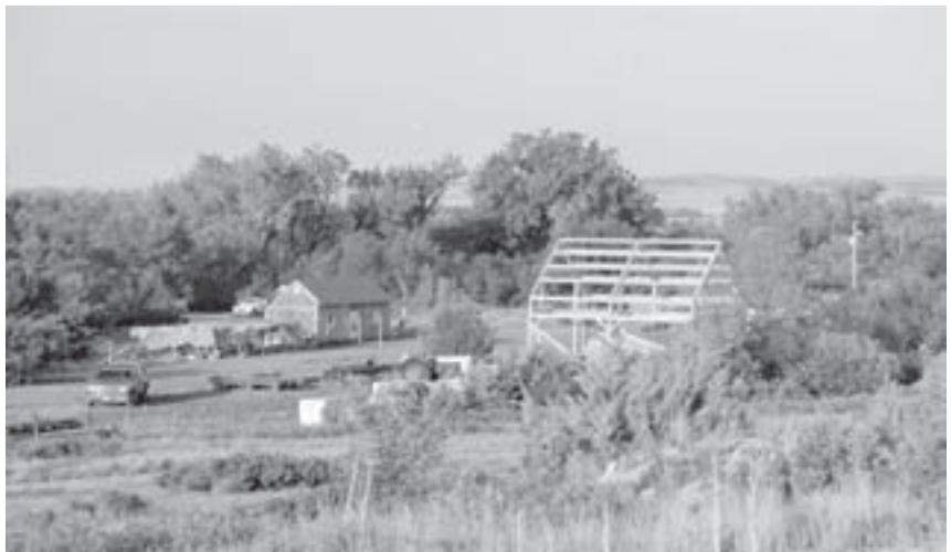
La granja Despreciable en Extremos Delgados. El invernadero (izquierdo) era el proyecto de 2001. La pared del norte se acabada con cáñamo/wattle de arcilla & embadurna. Esto es uno de dos invernaderos construyeron por Fox Maple en 2001. Al derecho es la armazón completado, se construyó en el verano de 2002.
