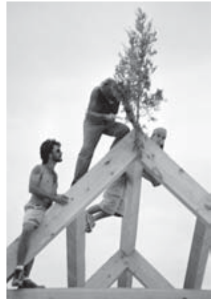
Tom Cook esta clavado el arbol de techo en una armazon que construyó en el verano 2002 taller.
